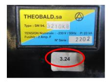
Les chaudières dont la version est antérieure à « 3.20»; Numéro de chaudière antérieur 0118.... » (si le module n'a pas été remplacé) ne peuvent pas recevoir ce kit d'adaptation.
